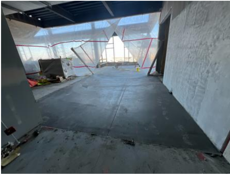
Concrete pour backs in the vestibule area
